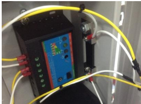
รูปที่ 4 ชุดควบคุมการชาร์จแบตเตอรี่ ทำหน้าที่รับพลังงานจากแผงโซลาร์เซลล์ ชาร์จเก็บไว้ในแบตเตอรี่
